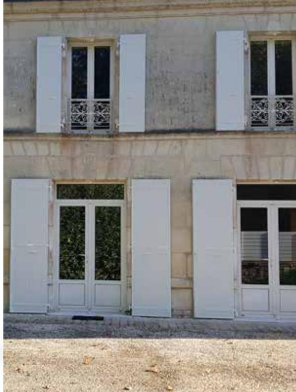
Volets en configuration Contre-pentures et ferrage en coloris RAL 9016.
